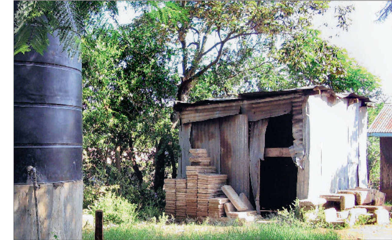
Der Schopf konnte dank Spenden abgebrochen und durch ein Restaurant mit Küche und Geräteraum ersetzt werden. (ü)
